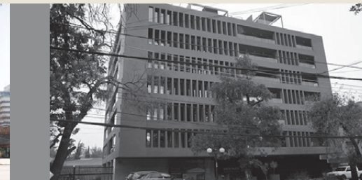
Edificio Hernando de Aguirre - Surinvest
