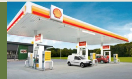
Estación de Servicio Shell Arauco
